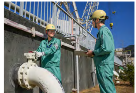
▲隔離・復旧作
