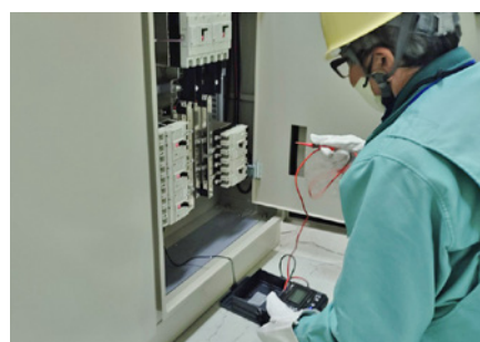
▲建物設備管理(電気設備点検)
